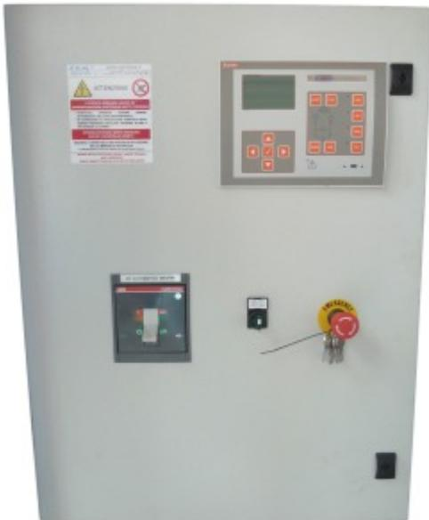
**Centralina RGK800 SA con multimetro (voltmetro, amperometro frequenzimetro, contaore e voltmetro batteria).**
