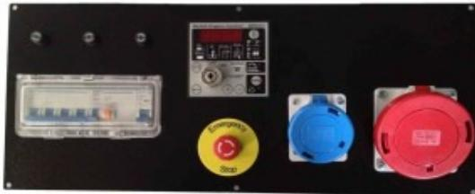
**Centralina BE24 con multmetro (voltmetro, amperometro, frequenzimetro, contatore e voltmetro batteria)**
